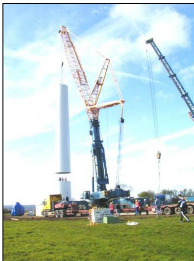
Photo n° 5 : Vue du montage d'un fût d'éolienne
