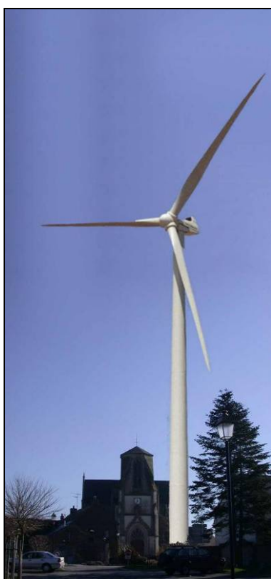
Photo n° 6 : Vue des dimensions relatives du clocher d'Assérac et d'une éolienne de 100 mètres de hauteur
